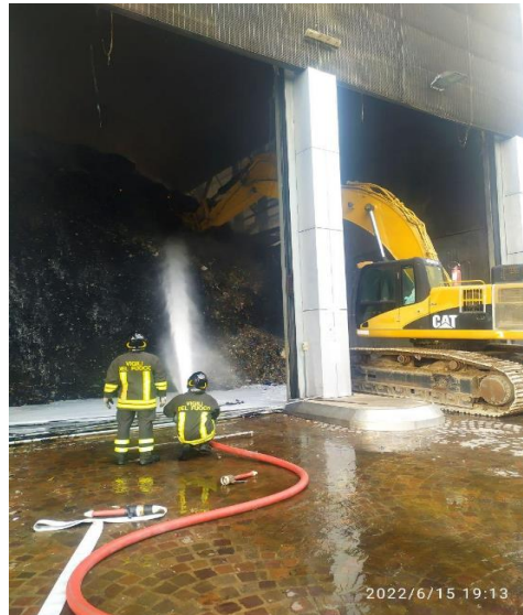
inertizzazione del combustibile attraverso le operazioni di raffreddamento e smassamento..
